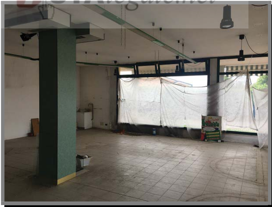
Vista interna sud-ovest
