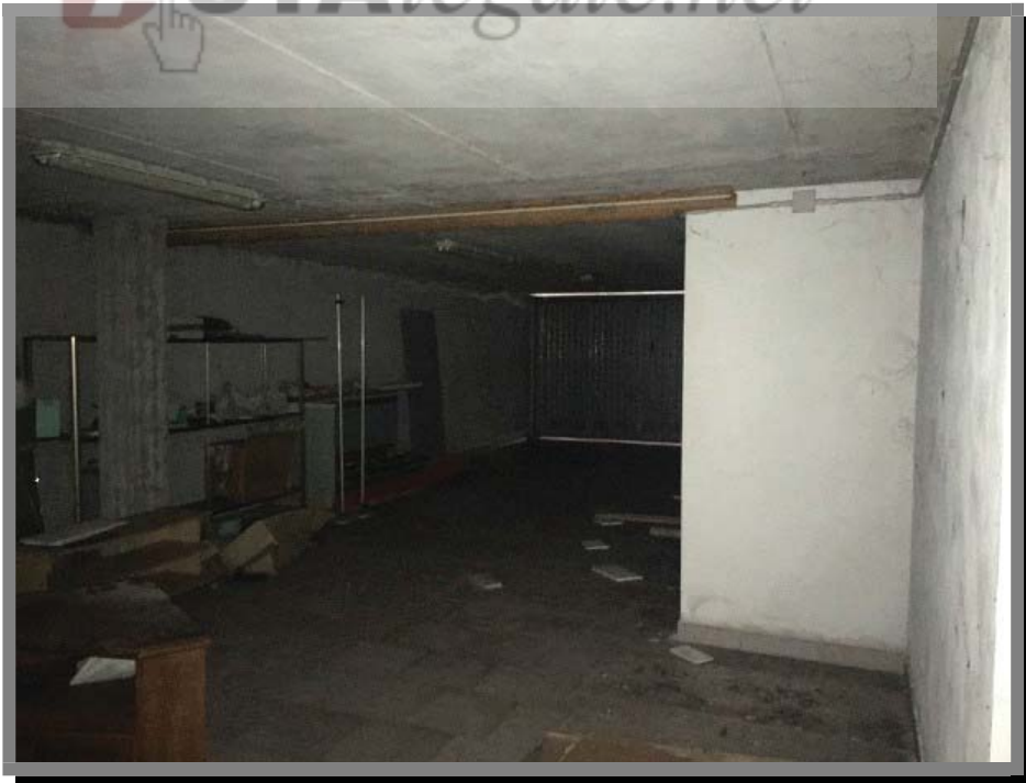
Vista interna magazzino est
