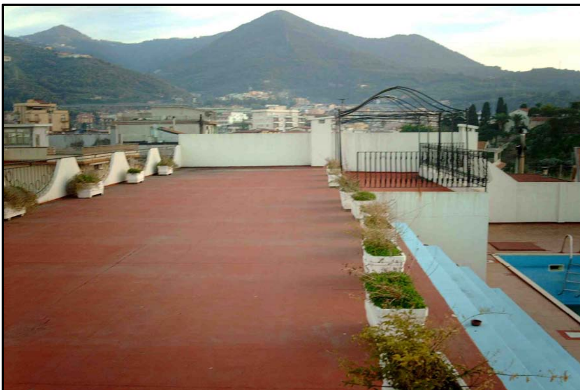
Foto n. 36 – terrazza vista dal lato nord piano quarto
