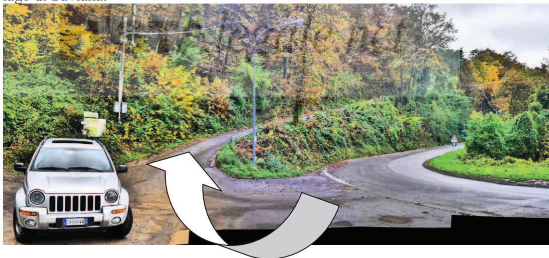
Strada di accesso al complesso
