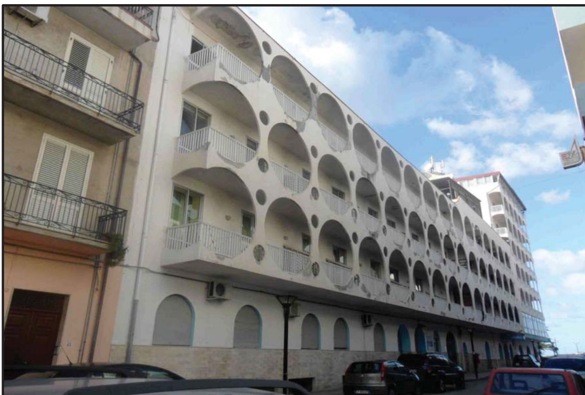
Foto n. 38 – vista fabbricato dal lato sud di via Marina
