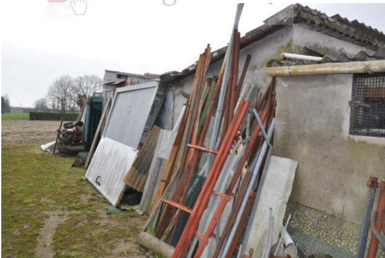
18 Fabbricato lato Est , adibito a deposito materiali.
