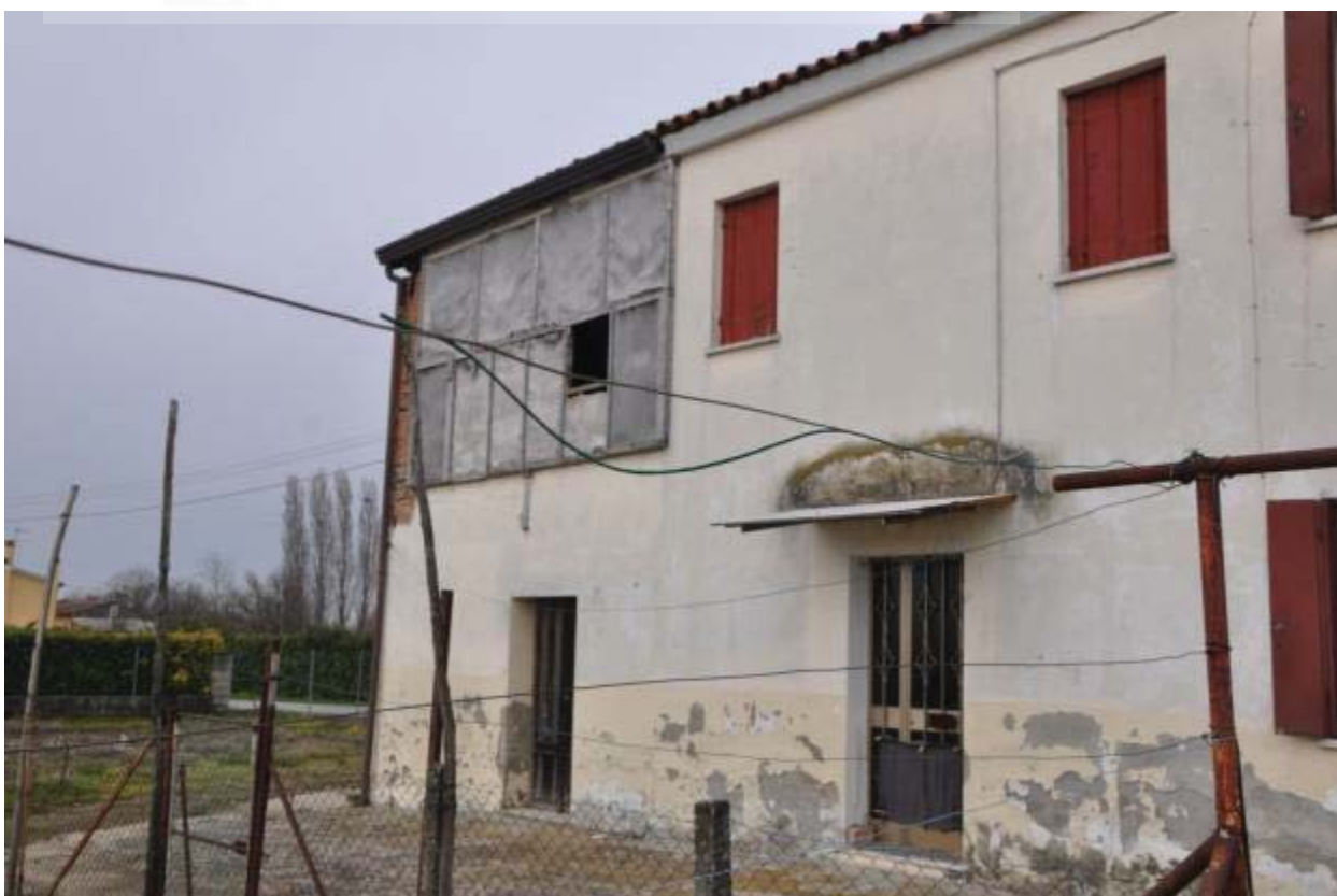
10 Porzione di piano primo, attualmente al grezzo.
