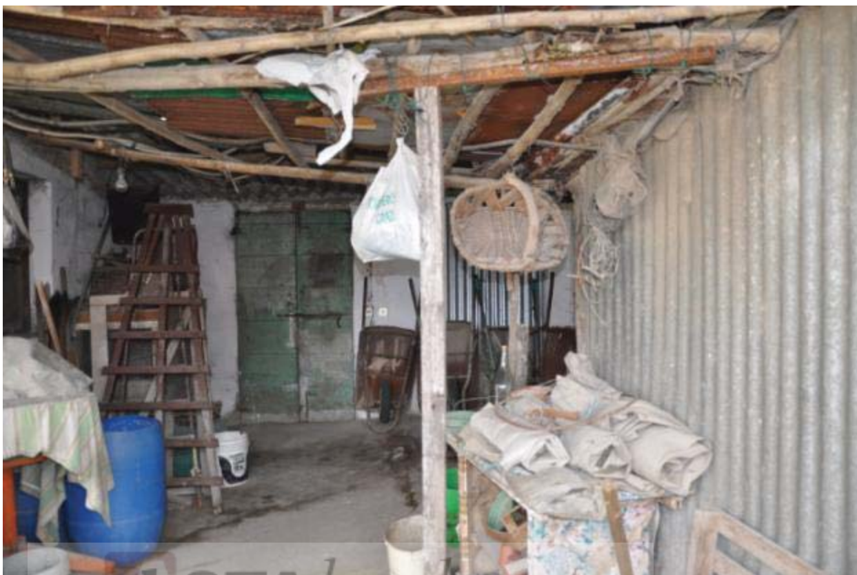
17 Porzione di interno del fabbricato.
