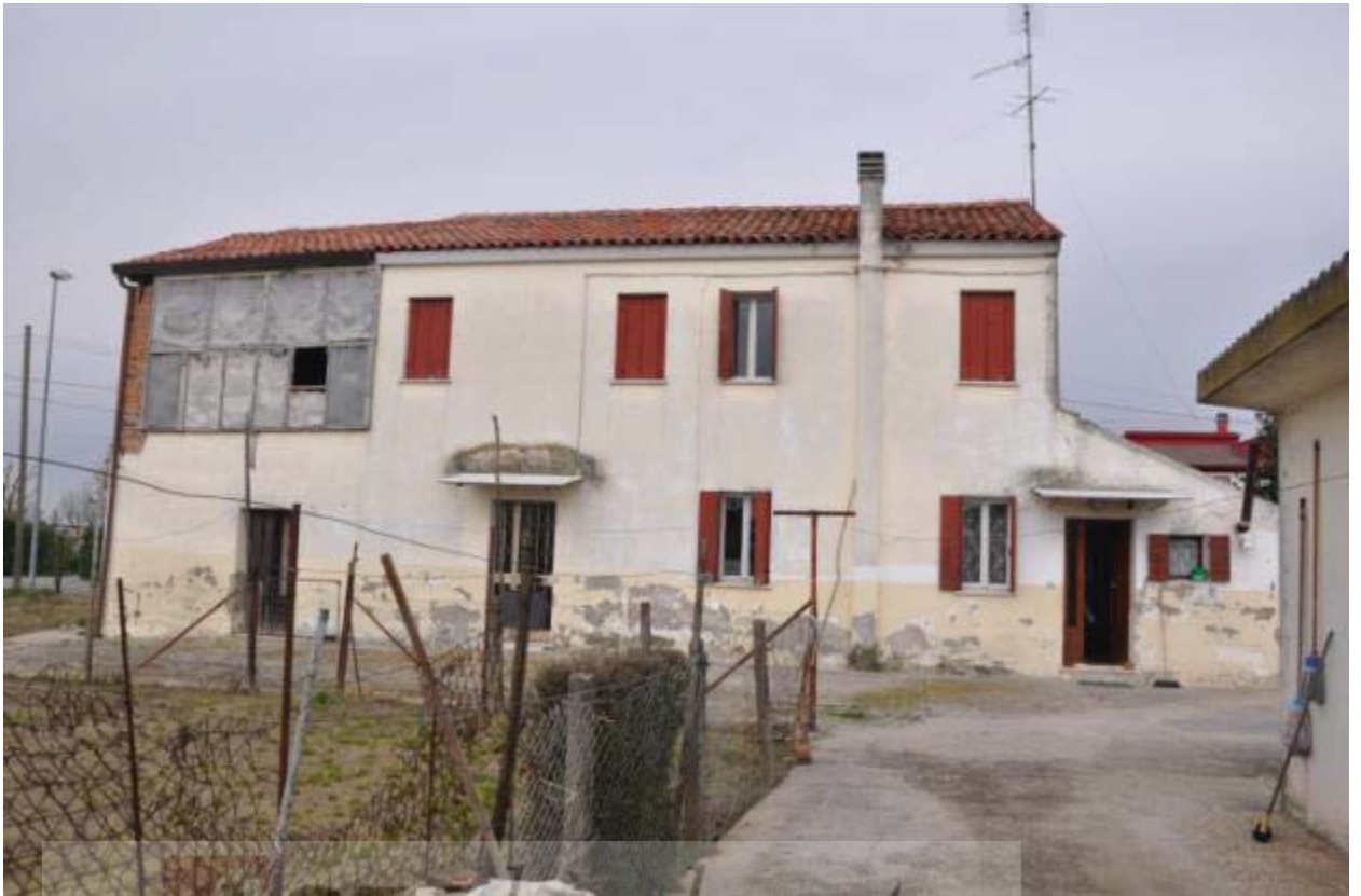
7. Vista dell'immobile lato Sud.
