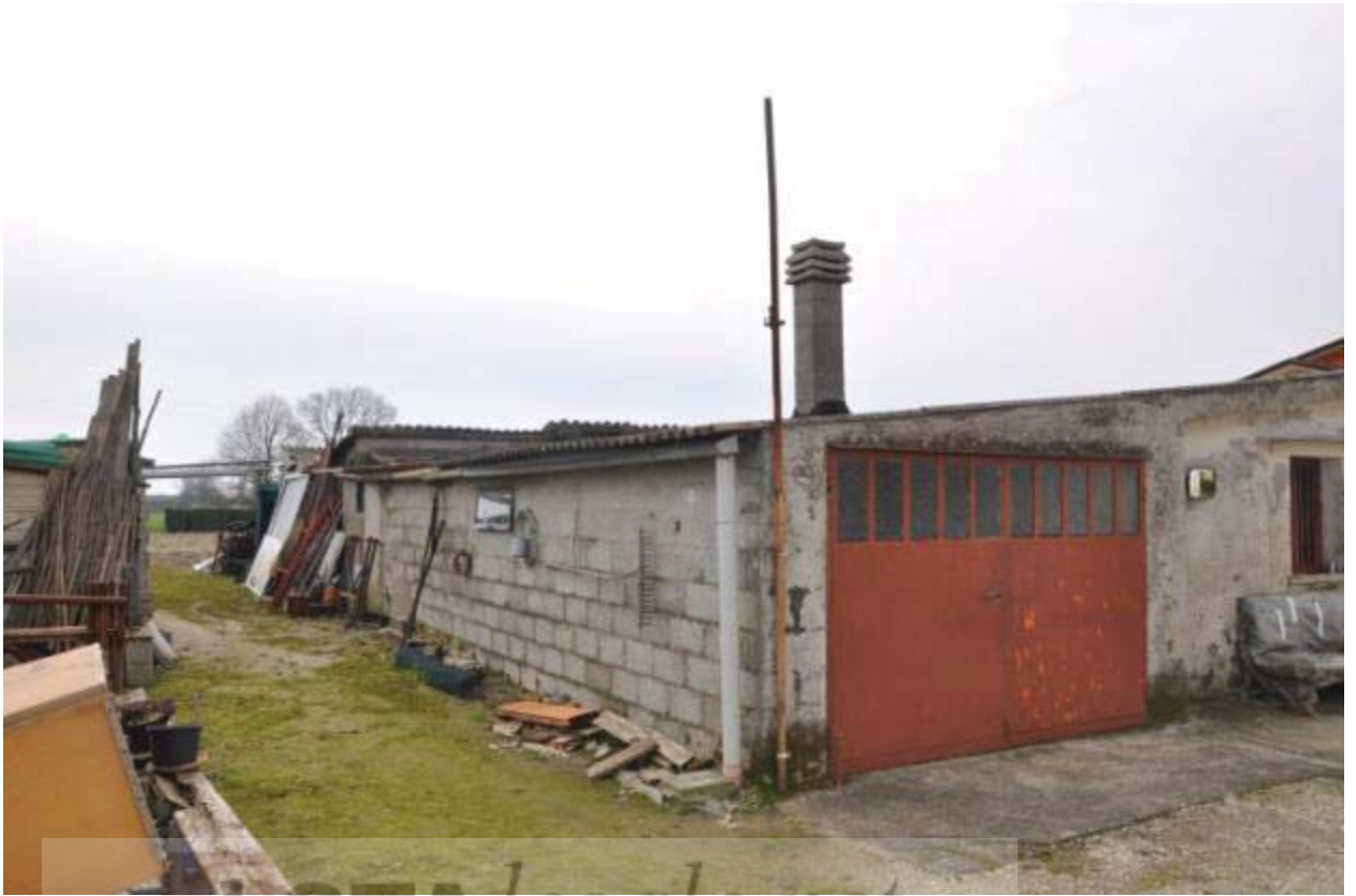
11 Fabbricato lato Nord, antistante la casa destinato ad uso ripostiglio, porcile e pollaio.
