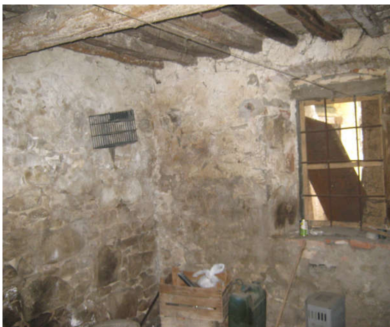
Foto 8 – 364 / 10 Cantina P. Terra -
