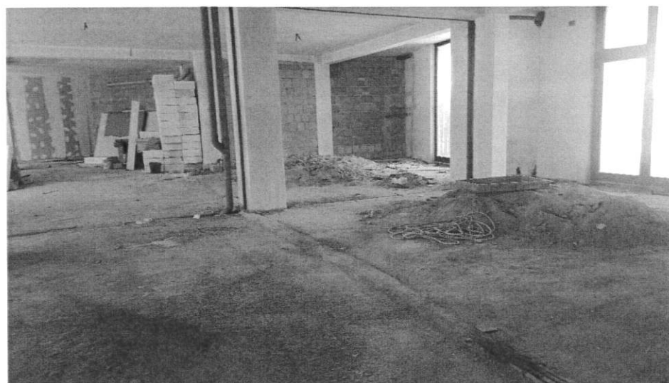
Interno unità sub. 135 completamente allo stato grezzo
