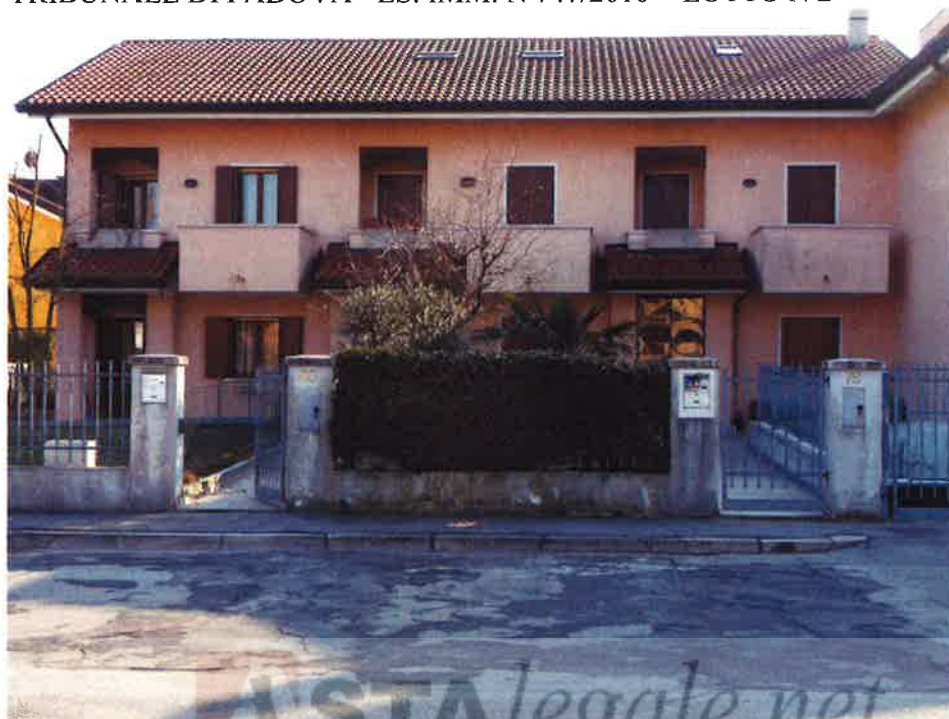
VISTA PROSPETTO PRINCIPALE DA VIA FALCONE
