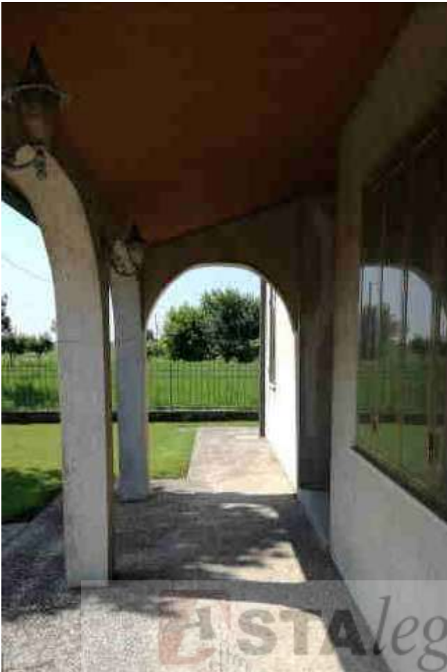
Veduta del portico di ingresso
