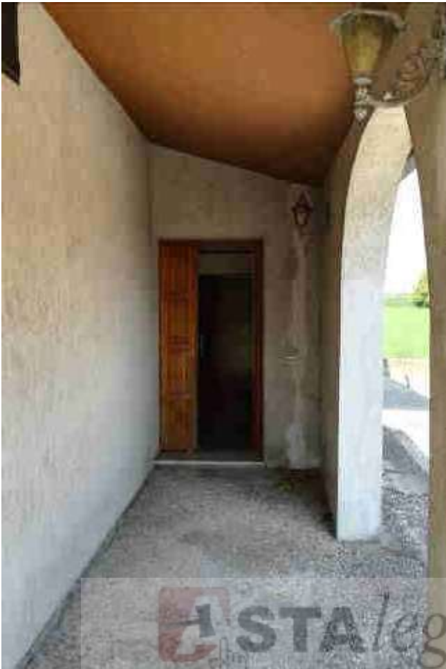
Veduta del portico di ingresso
