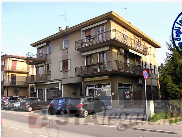
1 – Vista da SudEst Fabbricato condominiale
