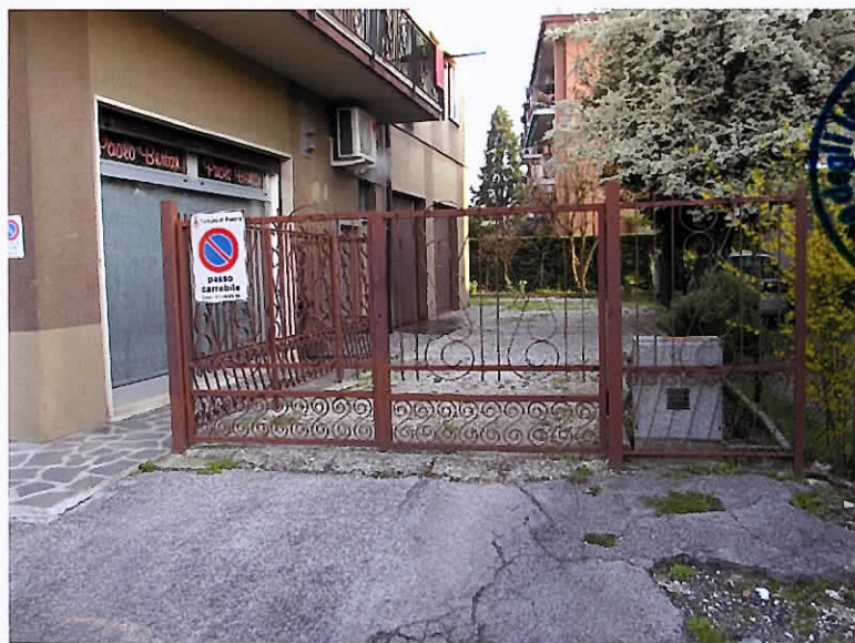
3 – Ingresso carraio (Via San Bellino) condominiale
