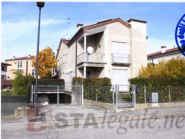
1 – Vista da SudOvest (Via Manin) porzione Bifamiliare
