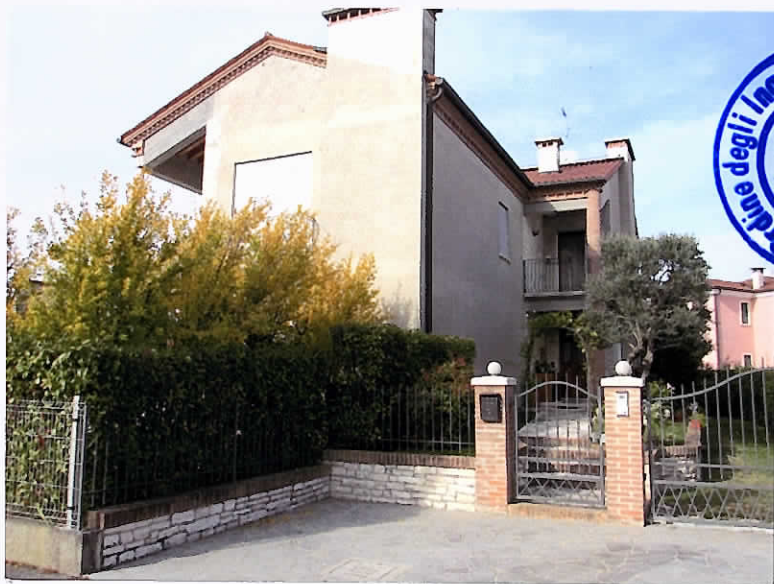
3 – Vista da SudEst (Via Manin) porzione Bifamiliare
