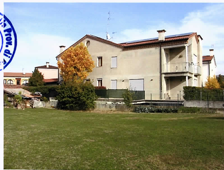
2 – Prospetto Ovest del fabbricato
