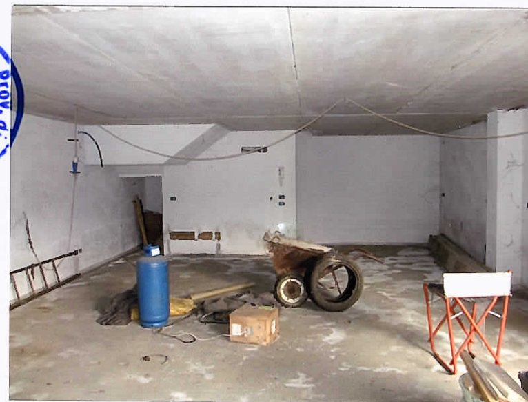
4 – Particolare di Interni: Garage P.S1
