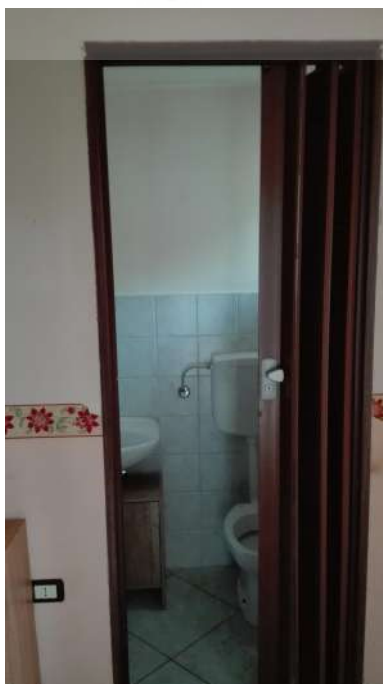
Bagno – locale di deposito
