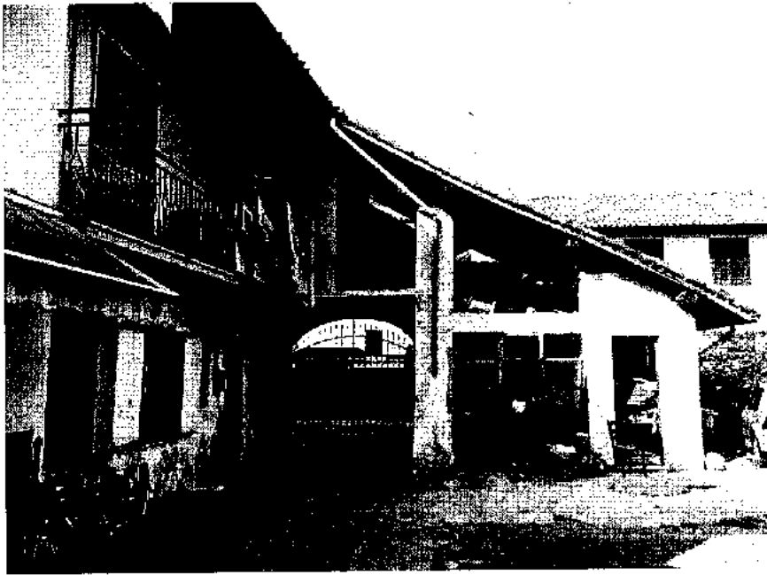
Figura 6_Vista d'insieme dell'immobile sito in Via Fosso n. 4 – Gambolò (PV)
