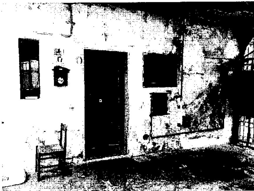
Figura 8_Vista esterna della porta di ingresso del bene in esame
