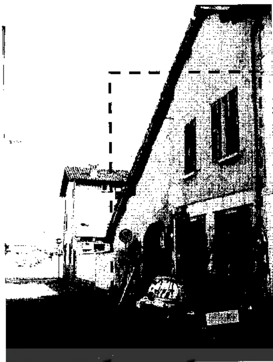
Figura 2_Vista esterna dello stabile in Via Fosso n. 4 Gambolò in cui è posto il bene in esame
