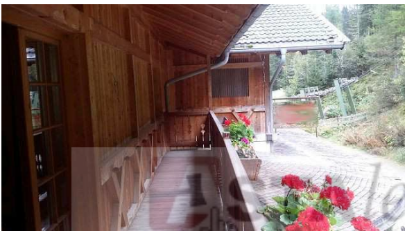
Foto 35: Vorgesetzte Holzfassade
