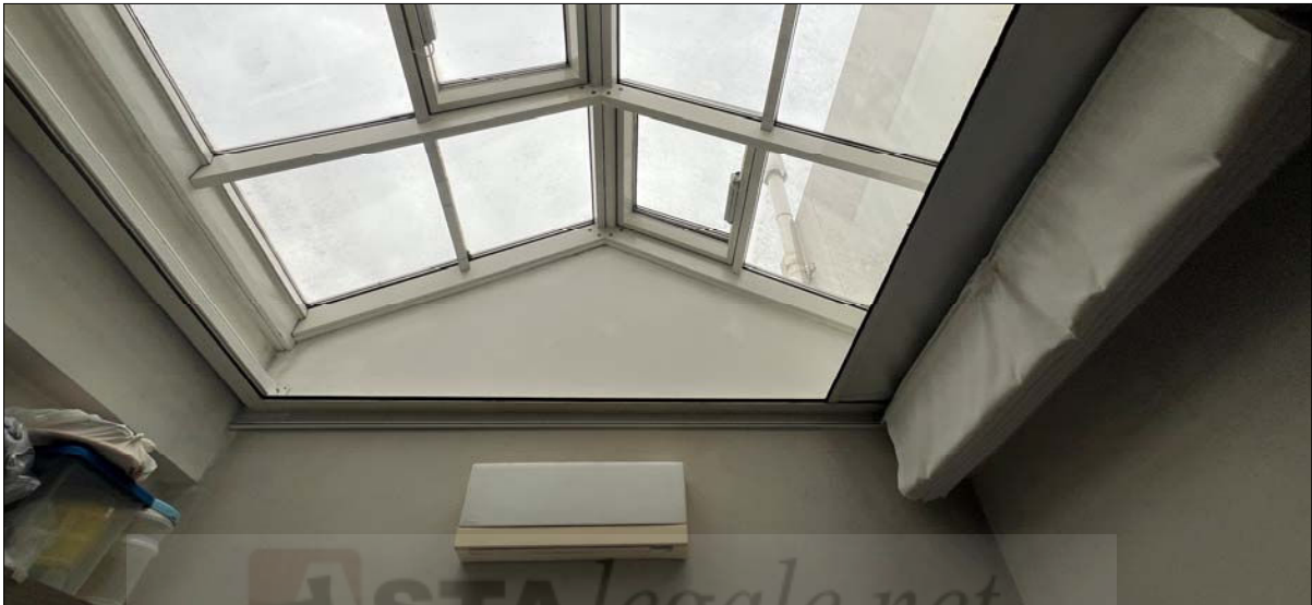
Vista della soprastante copertura in vetro
