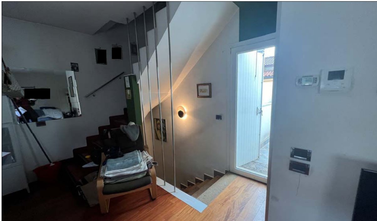
Vista della scala che conduce al piano secondo-sottotetto
