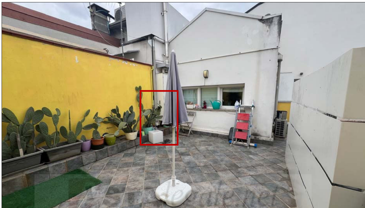
Vista della terrazza al piano primo In rosso posizionamento della grondaia
